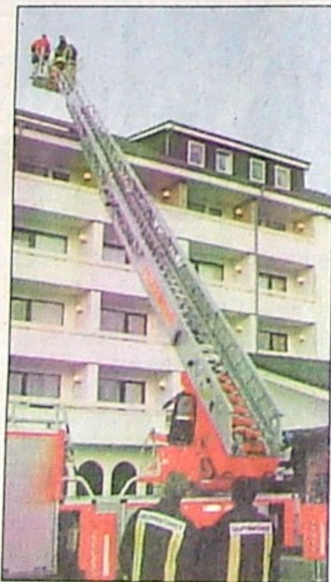
Eine solche 30-Meter-Leiter braucht die Feuerwehr. 2005 wurde sie am Hotel Friesenhof vorgeführt. Foto: Archiv
